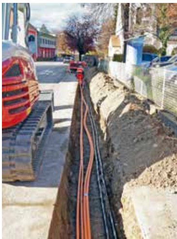
Verlegung der Glasfaserkabel auf Höhe der Evangelischen Kirche
