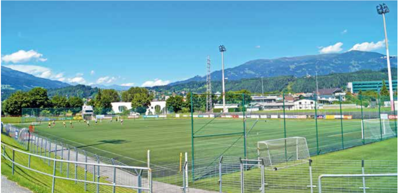
Das in die Jahre gekommene Goldeckstadion wird 2021 um 2,1 Millionen Euro saniert
